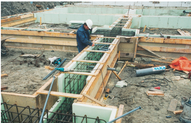
Fig. 25: Formwork with Styrodur.
